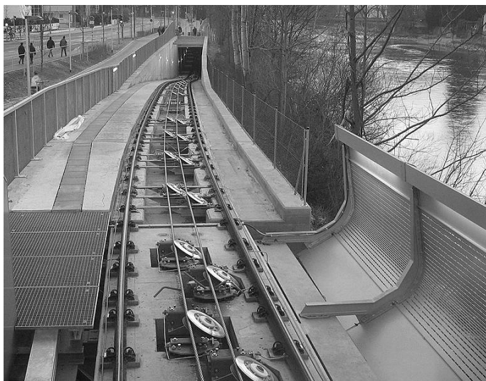
Fot. 2. Konstrukcja jezdna z krążkami trasowymi (fot. Steven Dale)
