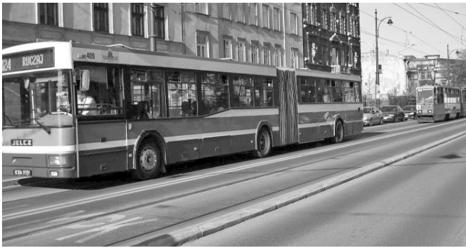
Fot. 5. Kraków, ul. Lubicz – przykład pasa autobusowo-tramwajowego
