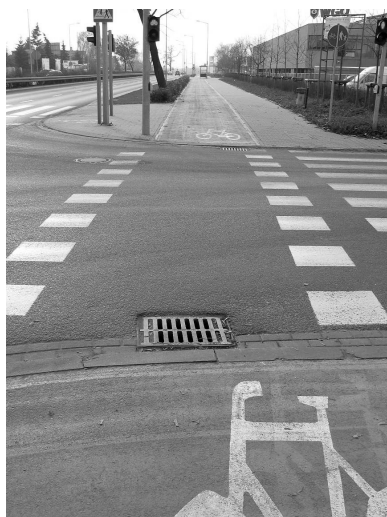
Fot. 4. Studzienka kanalizacyjna na przejeździe rowerowym stanowi swoistą „pułapkę” na rowerzystów (ul. Głogowska) (Fot. Jakub Łabędzki)
