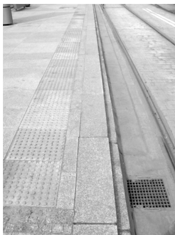
Fot. 12. Wyróżnienie skrajni peronu na przystanku „Bardzka” w kierunku Gaju. Widoczny jest również specjalny krawężnik, mający ułatwić obsługę przystanku przez autobusy (podjazd jak najbliższej krawędzi peronu), które w związku z obecną organizacją ruchu jednak się tu w ogóle nie zatrzymują.
