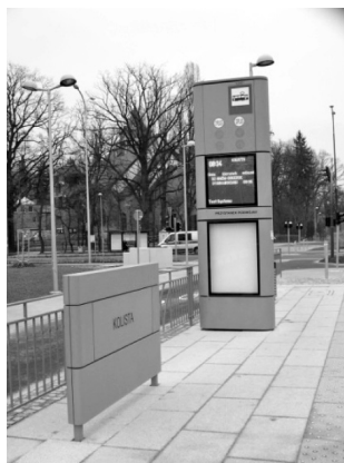
Fot. 5. Jeden z potężnych słupów przystankowych, jakie stoją na większości przystanków przy nowo wybudowanych trasach tramwajowych, oraz jedna z tablic z nazwą przystanku, ustawionych przy wszystkich nowych miejscach zatrzymań
