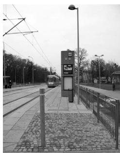
Fot. 3. Wybrukowane nierówną kostką dojście do nowo powstałego przystanku „Kolista” ze stojącym pośrodku słupkiem, na którym zainstalowany będzie przycisk detekcji pieszych na przejściu przez torowisko. W głębi widoczny potężny słup przystankowy, na którym nie umieszczono napisu z nazwą przystanku. Widnieje ona dopiero na osobnej tablicy niejako ukrytej za tym słupem. Po prawej fragment zadaszzonego parkingu dla rowerów.
