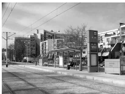
Fot. 1 Stylizacja przystanków zlokalizowanych przy nowo wybudowanych trasach tramwajowych na Kozanów (przystanek „Pilczycka (Anima)”)
