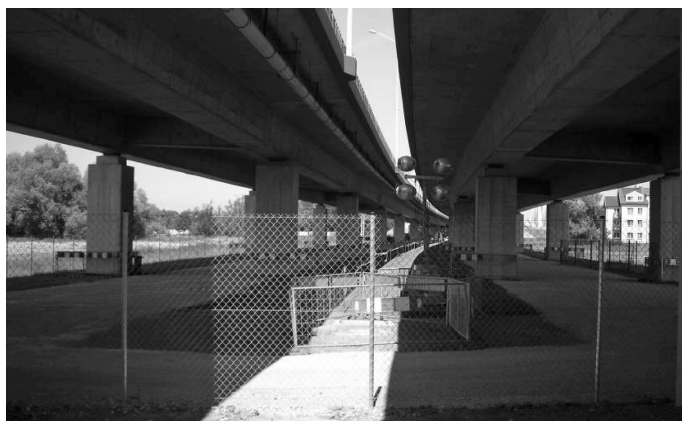
Fot. 7. Parking (w budowie) pod estakadami AOW przy ul. Królewickiej (fot. D. Chylińska, 2012).
