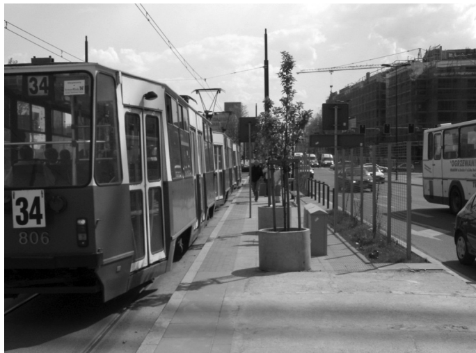
Fot. 1. Przejście przystanku tramwajowego w ramach nowej inwestycji wymuszające wejście pieszych na skrajnię tramwaju
