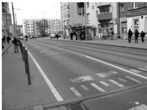
Fot. 2. Przystanek „Gajowa” na ulicy Glinianej: po lewej budzący pewne wątpliwo- ści co do koncepcji i sposobu wykonania przystanek wiedeński, po prawej – antyzatoka
