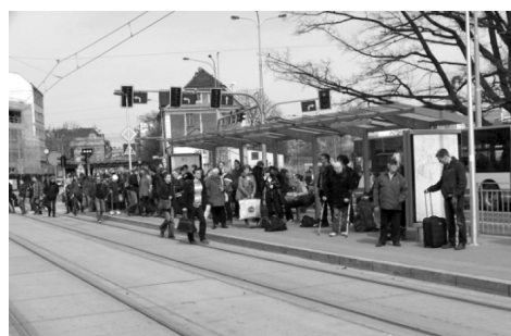
Fot. 6. Niedostateczna szerokość peronu na przystanku „Dworzec Autobusowy” w kierunku centrum, dodatkowo wprowadzone tu boczne ścianki wiat, utrudnia przemieszczanie się wyjątkowo licznych w tym miejscu pasażerów
