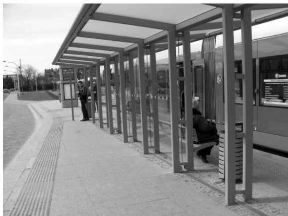
Fot. 8. Dwustronne wiaty przystankowe na przystankach w ciągu ulicy Świeradowskiej
