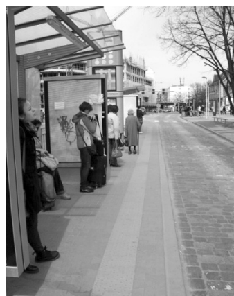
Fot. 7. Zbyt wąska wyspa na przystanku autobusowym „Dworzec Autobusowy” przeniesionym w pobliże miejsca zatrzymań tramwajów
