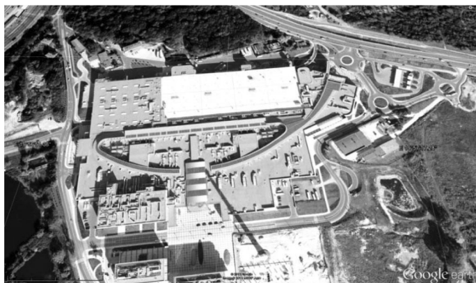
Rys. 3. Centrum Handlowe „Bonarka” Źródło: Google Earth
