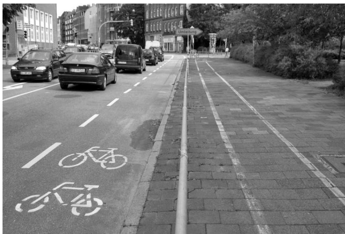
Fot. 1. Pas ochronny rowerowy (po lewej) i dawna droga rowerowa na chodniku (fot. M. Beim).
