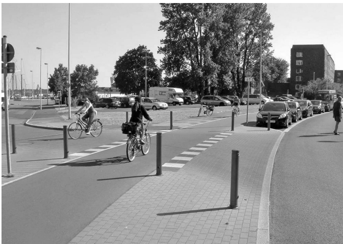
Fot. 3. Przykład prymatu nawierzchni drogi rowerowej i chodnika nad nawierzchnią drogi prowadzącej do ulicy wyższej klasy. Rozwiązanie to stanowi nie tylko element uspokojenia ruchu oraz poprawy bezpieczeństwa pieszych i rowerzystów, ale również określa pierwszeństwo (fot. M. Beim).
