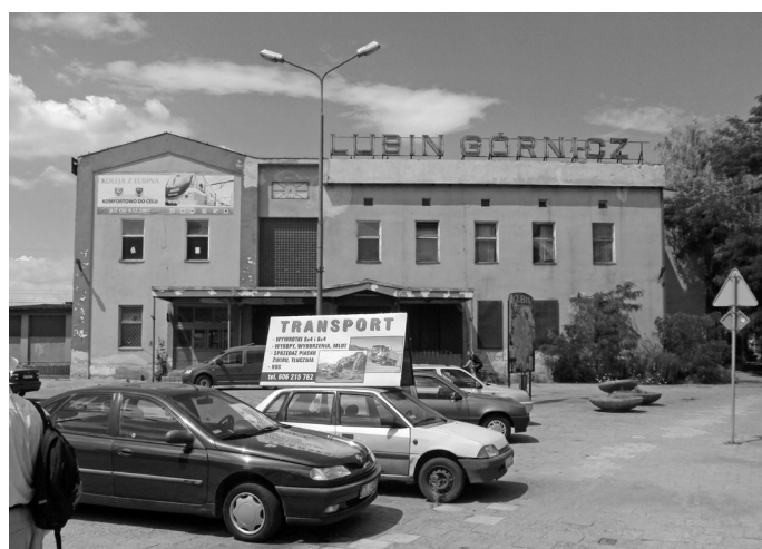
Fot. 1 i 2. Stan istniejący budynku dworca stacji kolejowej Lubin Górniczy.
