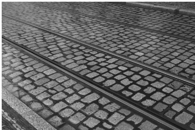
Fot. 3. Fragment ulicy w strefie ruchu pieszego, na którym dopuszczony jest ruch tramwajów i rowerów. W celu uzyskania wyższej równości nawierzchni przestrzenie między kostkami wypełnione są asfalto-kauczukiem (fot. Michał Beim).
