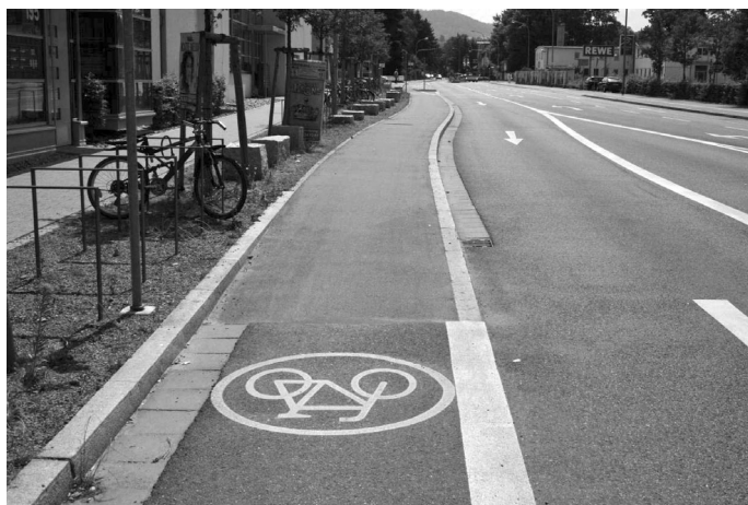
Fot. 1. Droga rowerowa przechodząca w pas rowerowy. Przejście odbywa się w sposób płynny, a rowerzyści nie napotykają przeszkód w postaci krawężników (fot. Michał Beim).
