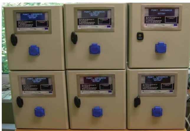
Rys. 3. Terminale garażowe w trakcie testowania
