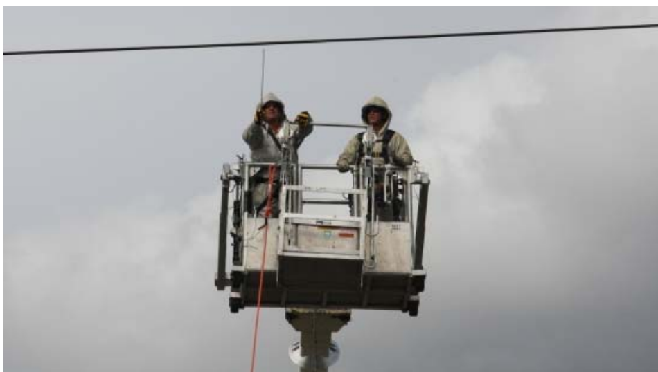
Rys. 2. PPN metodą „na potencjale” prowadzone z izolowanych platform umieszczonych na podnośnikach; www.livelinesolutions.com – góra, www.bchydro.com (fot. Cara Grimshaw) – dół
