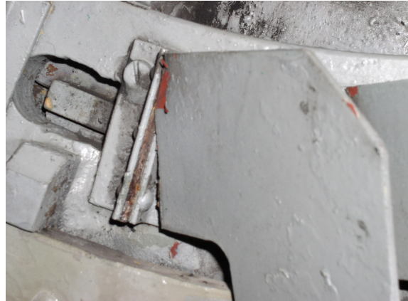
Rys. 9. Miejsce pęknięcia łopatek wentylatora
