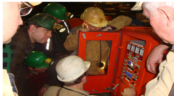
Rys. 10. Prace serwisowe na prostowniku w KWK
