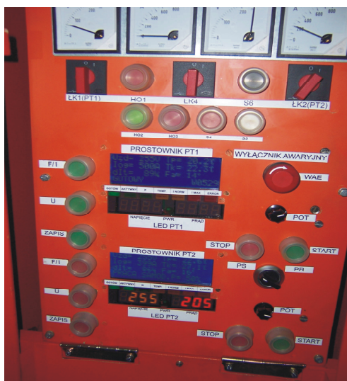
Rys. 4. Przykładowy ekran wizualizacyjny prostownika trakcyjnego w KWK w czasie pracy
