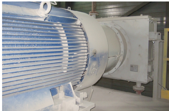
Rys. 3. Zewnętrzna chłodnica wodna silnika Sf 500Y8Ds 1200 kW 690V
