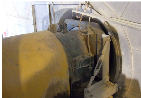
Rys. 4. Wyważarka dynamiczna dla wentylatora obiegowego silnik DKK 560-6/063, 630 kW
