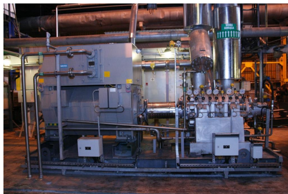
Rys. 6. Silnik na stanowisku pracy
