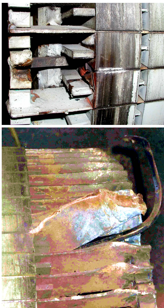
Rys. 11. Uszkodzenia uzwojenia klatkowego wirnika silnika jednoklatkowego
