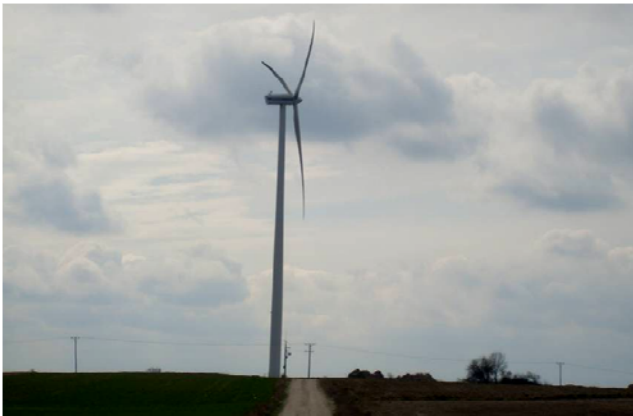
Rys. 1. Widok elektrowni wiatrowej o mocy S = 2 MVA przyłączonej do sieci SN
