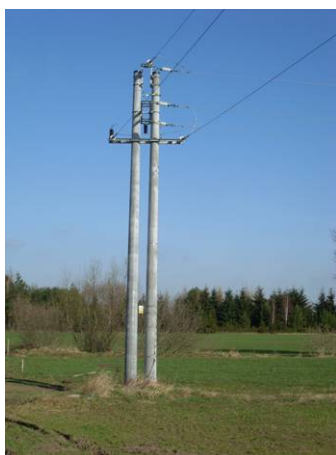
Rys. 18. Widok słupów funkcyjnych linii SN typu E:
