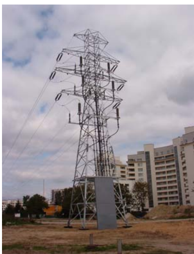
Rys. 1. Przykłady słupów linii 110 kV z przejściem na podziemną linię kablową: a) słup krańcowy, b) słup rozgałęźny
