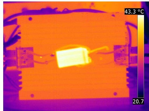
Rys. 8. Zdjęcie termowizyjne przekształtnika
