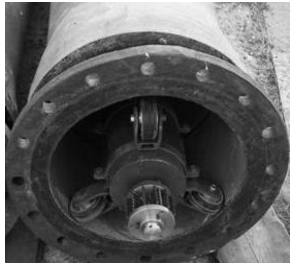
Rys. 1. Umiejscowienie silnika podczas procesu cementowania słupa
