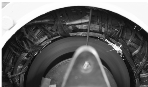
Rys. 13. Przeskok iskry podczas rozruchu silnika
