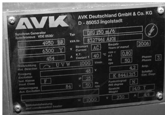
Rys. 8. Tabliczka znamionowa generatora
