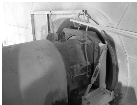
Rys. 14. Wyważarka dynamiczna dla wentylatora obiegowego silnik DKK 560-6/063, 630 kW
