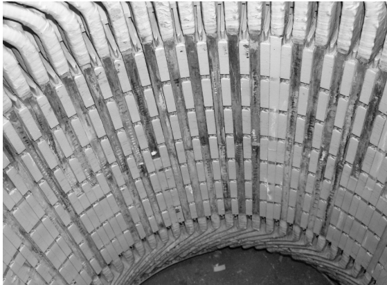
Rys. 15. Rewizja silnika 1000 kW 6 kV DSE 1318-6
