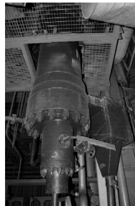
Rys. 2. Widok zespołu pompy cyrkulacyjnej NK
