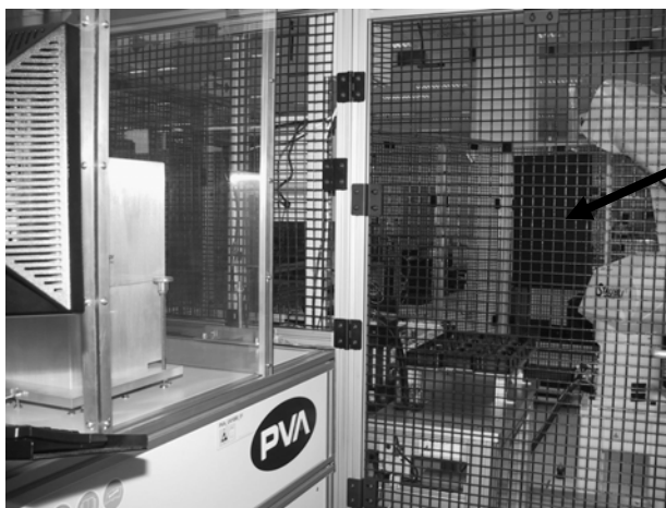
Rys. 3. Widok urządzenia do utwardzania na tle ogrodzenia obszaru robota z zaznaczoną dodatkową osłoną na ogrodzeniu (fot. autor)
