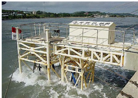
Rys. 4. Elektrownia z turbinami Gorlova
