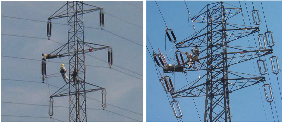
Rys. 1. Przykłady prac pod napięciem – metoda „z odległości”
