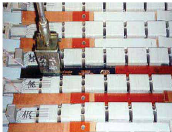
Rys. 5. Anteny paskowe umieszczone w żłobkach
