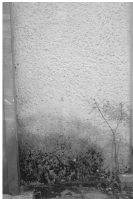
Rys. 1. Zawilgocenie ścian budynków [1]:
