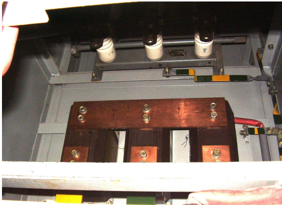
Rys. 6. Zwoła umożliwiająca wykonanie zwarcia udarowego
