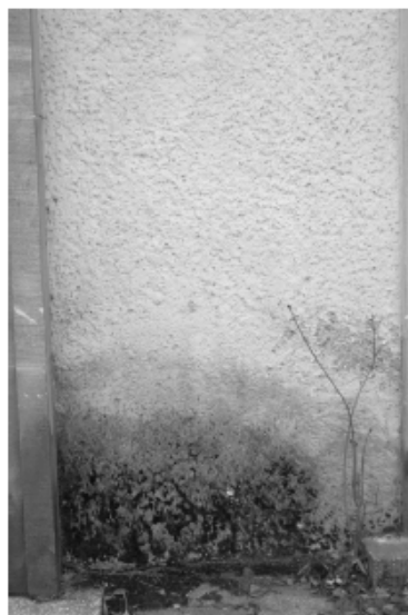
Rys. 1. Zawilgocenie ścian budynków [1]: a) wizualizacja procesu zawilgocenia ściany, b) uszkodzenia ściany spowodowane zawilgoceniem
