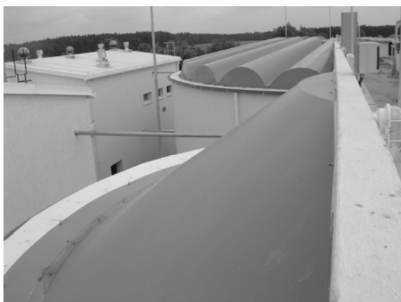
Rys.9. Słupia Kapitulna (Polska). Zbiorniki Dn18000 oraz Dn9000 z pomostem; konstrukcja podparta na pomoście oraz koronie zbiornika
