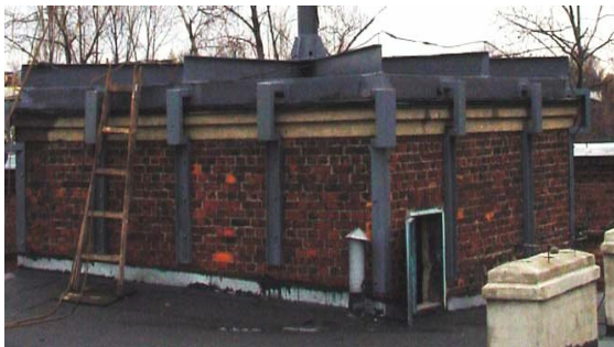
Rys.2. Podstawa zamocowania masztu wiatraka
