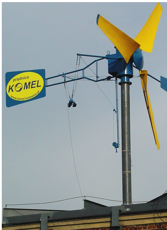
Rys.6. Wiatrak o mocy 6 kW wybudowany na dachu Ośrodka Komel (w Sosnowcu)
