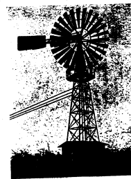
Rys. 1. Widok nowoczesnego silnika wietrznego do napędu prądu (na zdjęciu widoczne są przewody do odprowadzania energii elektrycznej).
