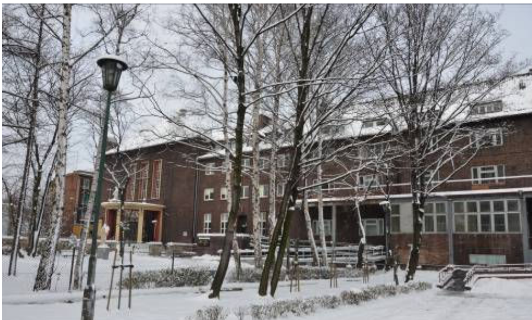
Ryc. 19. Elewacja płd. kościoła Św. Kamila (Domu Związkowego) i Kliniki Położnictwa ( Zakładu opiekuńczo-leczniczego). Widok z Placu Traugutta (Kamiliańskiego). Źródło: fot. autorka.
