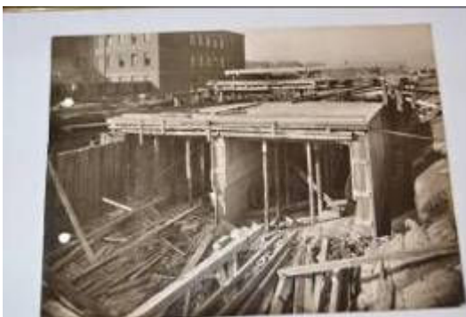
Ryc. 16. Zdjęcie prac inżynierskich przebudowy ciek wodnego w obrębie Placu Kamiliańskiego. Źródło: Dariusz Walerjański.
