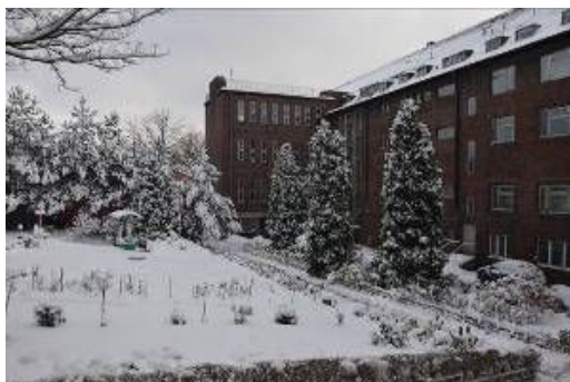
Ryc. 27. Elewacja półn. Kliniki Położnictwa (Zakładu opiekuńczo-leczniczego). Wewnętrzny ogród i drogi dojazdowe. Źródło: fot. autorka.
