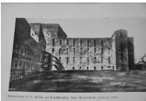
Ryc. 32. Rysunek elewacji wschodniej Kościoła Św. Kamila. Źródło: Josef Habel: Dominikus Böhm Ein Deutscher Baumeister . Regensburg 1943, s.70.
