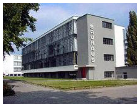
Ryc. 8. Walter Gropius - Budynek Bauhausu w Dessau, 1925 Źródło:
