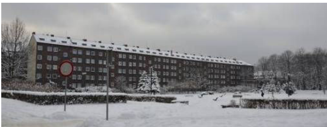
Ryc. 38. Elewacja północna budynku mieszkalnego przy ul. Góry Św. Anny. Widok z Placu Traugutta. Po prawej fragment alei kasztanowej. Źródło: fot. autorka.
