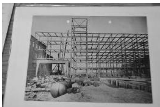
Ryc. 34. Konstrukcja stalowa Szkoły Zawodowej (dziś Klinika Stomatologii) Po lewej nitowane ramy przejazdu ulicznego. Źródło: Dariusz. Walerjański.
