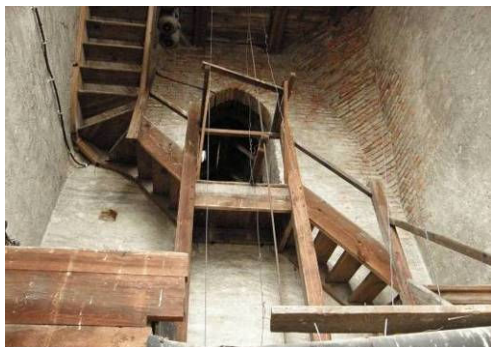
Ryc. 17. Drewniane schody we wnętrzu wieży wraz z otworem drzwiowym prowadzącym pod więźbę dachową. Źródło: fot. H. Rutyna, XII.2008
