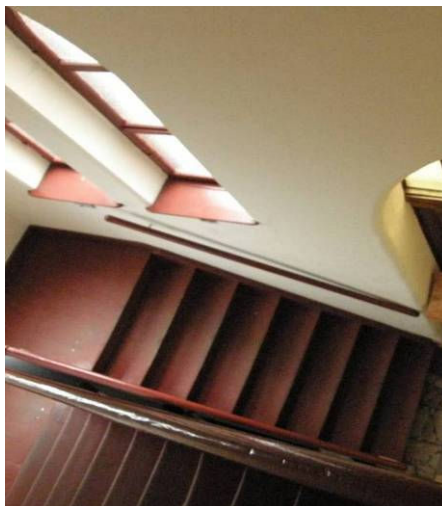
Ryc. 20. Klatka schodowa przyległa do wieży w części południowej – wejście na empore i chór muzyczny. Źródło: fot. H. Rutyna, XII.2008
