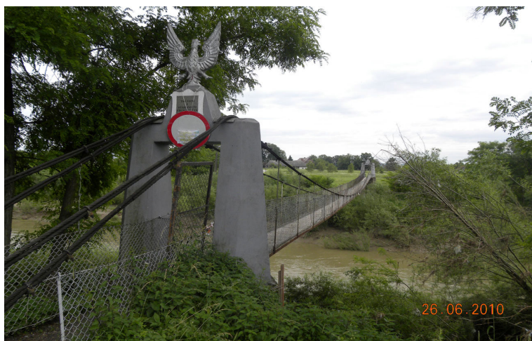
Ryc.1. Stan mostu przed wykonaniem ostatecznej ekspertyzy. Źródło: fot. własna.
