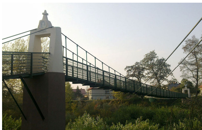
Ryc. 14. Odnowione pylony przeprawy. Źródło: fot. autora. Fig. 14. Bridge's renewed pylons. Source: photo by author.
