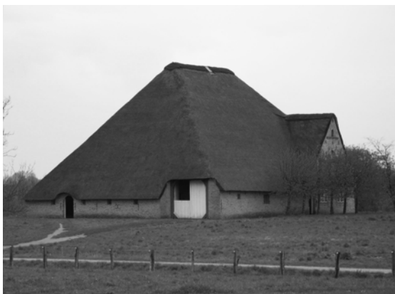
Ryc. 6. Budynek typu Haubarg w kształcie piramidy z 1653 roku (obecnie w skansenie Sorgenfri koło Kopenhagi). Źródło: foto. autora
