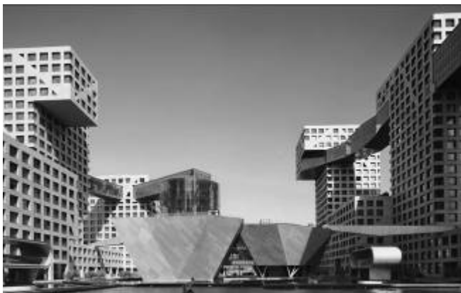
Ryc. 21. S. Holl, Hybrid Building . Źródło: A. Bulanda-Jansen, Otwarte bramy Pekinu , [w:] A&B, nr 1/2007, Kraków 2007
