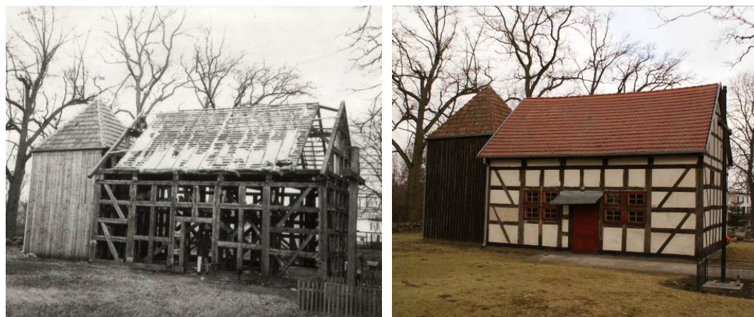
Rys. 12. Słajcino dwa widoki kościoła - w trakcie remontu generalnego i współczesny od strony południowo - zachodniej
