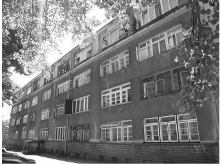
Ryc. 12. 1. Drugi blok na osiedlu TOR w Radomiu. Źródło: fot. M. Furtak
