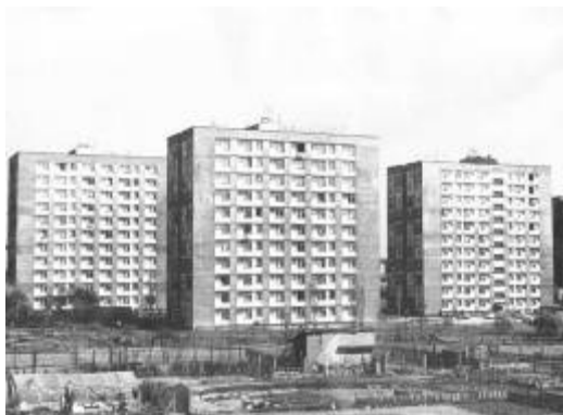
Ryc. 6. Okoliczne bloki, 1969 rok Fig. 6. Nearby blocks in 1969
