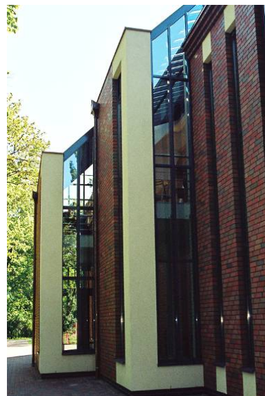
Ryc. 8. Fragment elewacji północnej kościoła. Fot. L. Czernik
