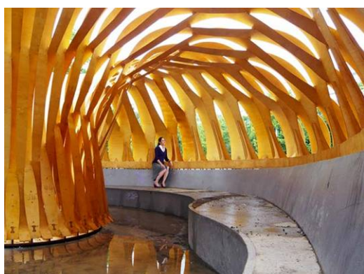
Ryc. 3. Ukończony pawilon Research Pavilion ICD/ITKE. Źródło: http://icd.uni-stuttgart.de .
