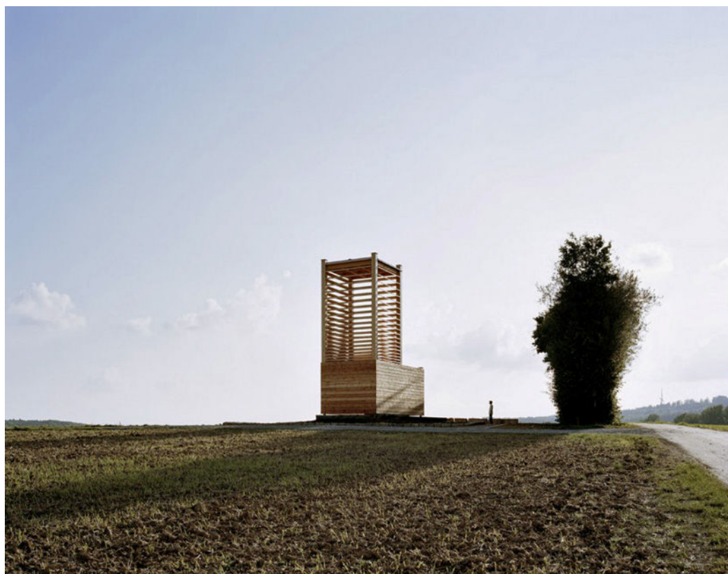
Ryc. 90. Niemcy. Bödigheim. Ekumeniczna Kaplica Polna. Skrajnie lapidarna forma wykonana w równie „czystej” technice ciesielskiej, stanowi rewelacyjną spójność z naturalno – kulturowym krajobrazem. Źródło: Saieh Field Chapel
