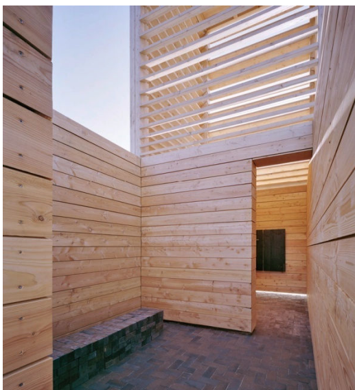
Ryc. 87. Niemcy. Bödighheim. Ekumeniczna Kaplica Polna. Współpraca międzynarodowego warsztatu akademickiego z warsztatami lokalnych rzemieślników zaowocowała bezpretensjonalną, praktyczną i naturalną architekturą.. Źródło: Saieh Field Chapel
