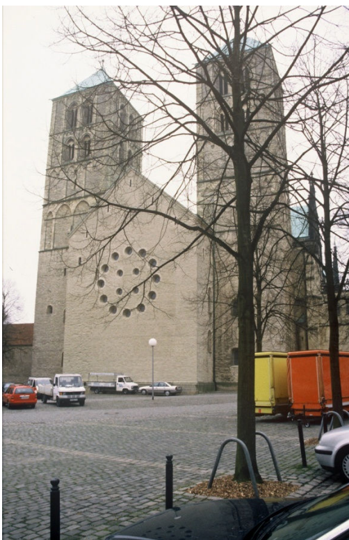
Ryc. 46. Niemcy, Münster. Katedra. 2007. Ośrodek oporu arcybiskupa i Kościoła Katolickiego Westfalii przeciw nazizmowi przed- i podczas drugiej wojny światowej. Po ciężkim zbombardowaniu Katedra została odbudowana z uwzględnieniem odważnych zmian w duchu nowoczesności. Źródło: Fot. autora
