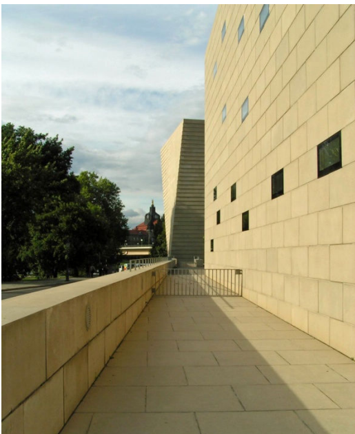
Ryc. 75. Niemcy. Drezno. Nowa Synagoga. Jedna z galerii zewnętrznych doprowadzająca do placu wspólnego znajdującego się między dwoma budynkami synagogi. Źródło: Fot. Przemysław Kowalski.
