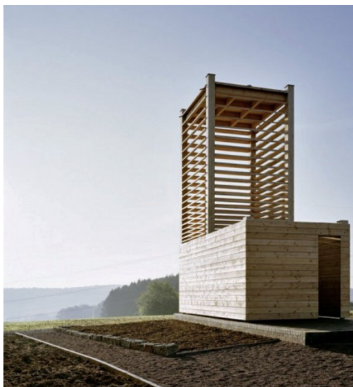
Ryc. 88. Niemcy. Bödighheim. Ekumeniczna Kaplica Polna. Progresywna idea kongregacji kościelnej w powiązaniu z eko- awangardowym podejściem architektonicznym odzwierciedliła się unikalnym dziełem. Źródło: Saieh Field Chapel
