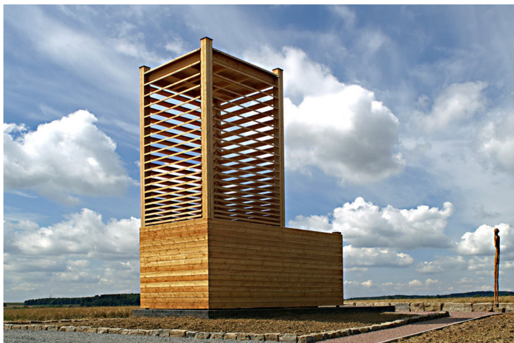
Ryc. 89. Niemcy. Bödigheim. Ekumeniczna Kaplica Polna. Ożywcza współczesna estetyka minimalistyczna znalazła idealne zastosowanie dla funkcji postępowych spotkań międzywyznaniowych. Źródło: Saieh Field Chapel
