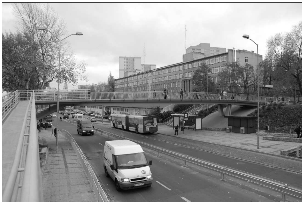
Ryc. 20. Kładka piesza – widok od strony ronda Giedroycia. Źródło: Google Earth, user: MarcinJot Fig. 20. Footbridge – view from Giedroycia roundabout. Source: Google Earth, user: MarcinJot
