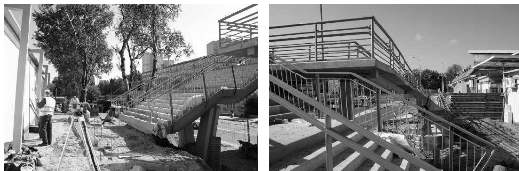
Ryc. 17. Etap realizacyjny – budowa kładki pieszej. Źródło: autor
