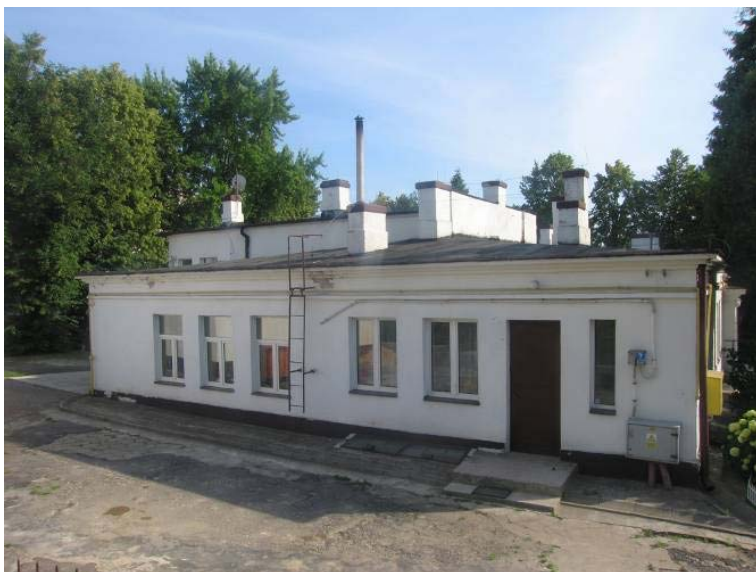
Ryc.5. Elewacja ogrodowa. Źródło: fot. M. Furtak 2007 Fig. 5. Garden elevation. Source: photo by M. Furtak
