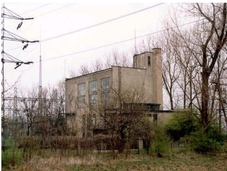
Ryc. 16. Budynek stacji transformatorowej w Starachowicach. Źródło: fot. M. Furtak 2007
