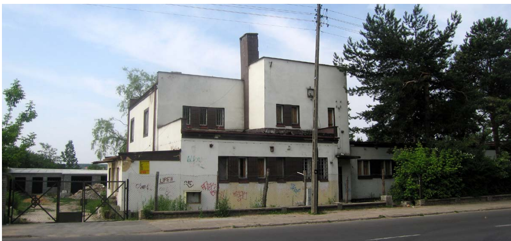
Ryc. 8. Dawny widok na pawilon przedszkolny. Źródło: fot. M. Furtak 2007
