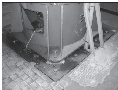
Rys. 4. Zamocowanie silnika do płyty
