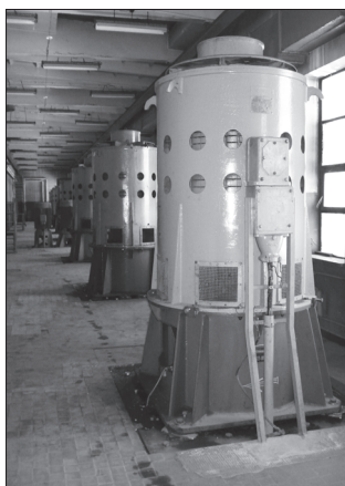
Rys. 2. Silnik elektryczny pompy
